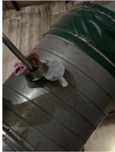
图4.2.1-2 喷漆晾干房废气处理后监测口
