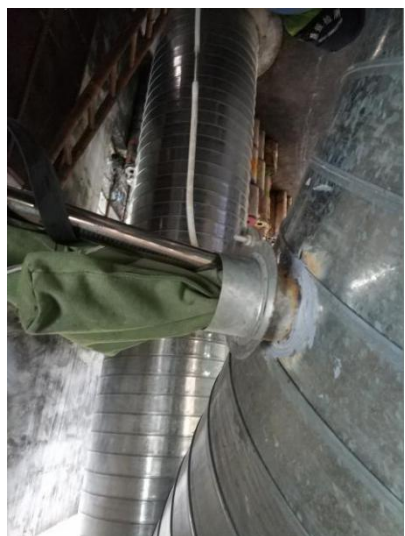
印刷废气处理后监测口
